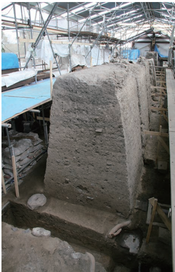
図4 東寺東築地断ち割り状況
